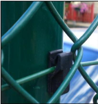
Le simple torsion est posé sur les fils ou câbles de tension par agrafage. La tension des fils et câbles se fait à l'aide de raidisseurs n°4, boulonnés sur les anneaux à visser des poteaux de départ, angle et rétention.
